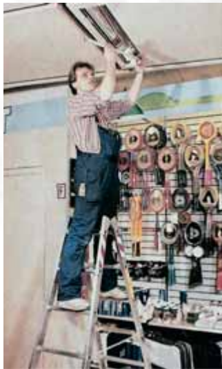
Bild 44: Sicherer Stand bei Über-Kopf-Arbeiten
